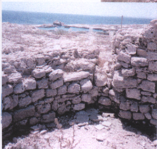
4 - ارتفاع البناء في المروحة أكثر من متر و نصف على سطح الأرض و قبلة فتحة الباب واضحة
